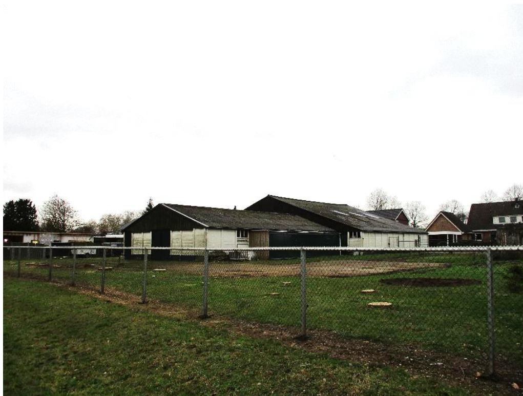
Figuur 1 De planlocatie is gelegen aan de Steenoven 118 te Wijchen en bestaat uit een betonnen muur zonder isolatie en een zadeldak met golfplaat, deels verhard terrein en een grasveld
