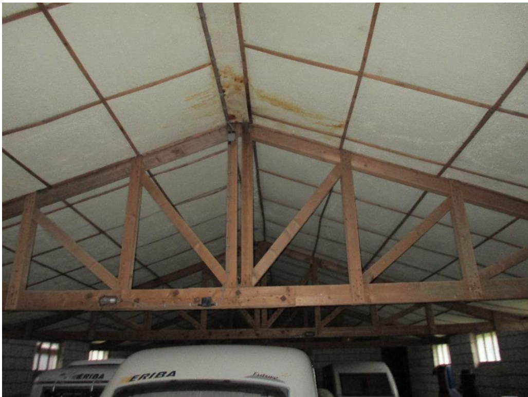
Figuur 4 In het achterste deel van de loods is het dak geïsoleerd met tempex platen
