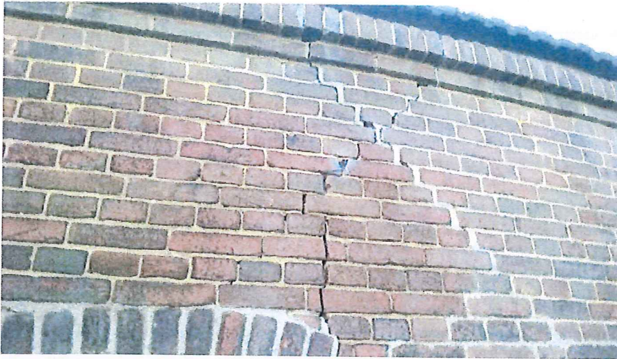
Bijlage 1: foto's balken dakconstructie en gevel
