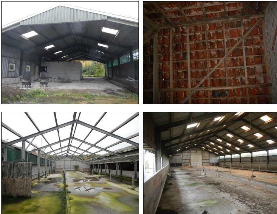
Figuur 9. Voorbeelden van de daken in het plangebied.
