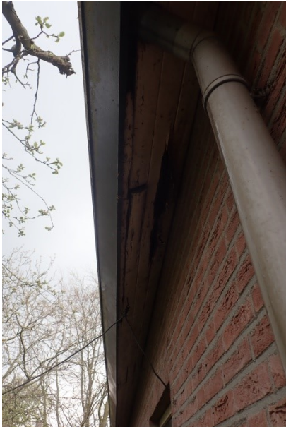
Foto 3: links, openingen onder het dak overstek.
