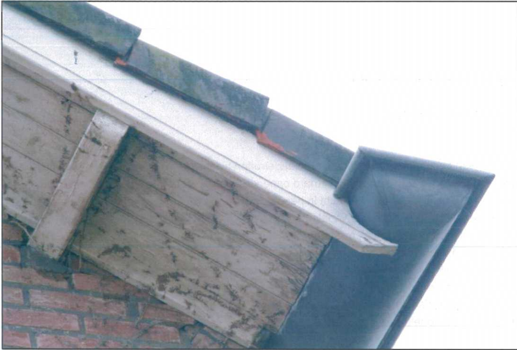
Figuur 8. Aanwezige hoekpannen aan het schoolgebouw aan de Boterstraat, potentieel geschikte invliegopeningen voor gierzwaluwen.
