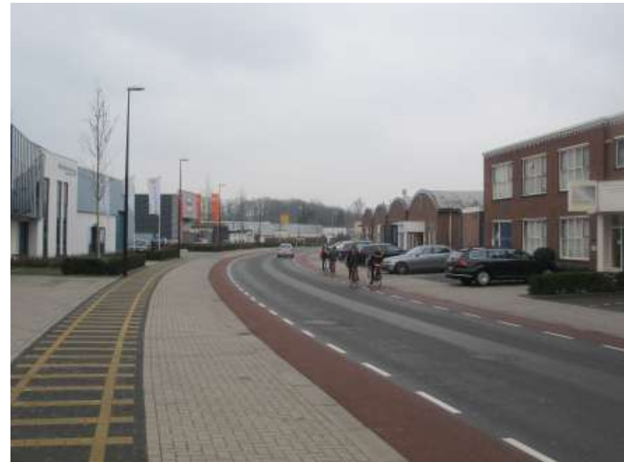
De Industrieweg volgt het oude GOLS-tracé van de spoorlijn Winterswijk-Zevenaar. De ligging van de spoorbaan is gevisualiseerd in de bestrating.
