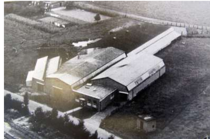
Luchtfoto uit 1952 van de HEVA aan de Parallelweg. Het linker deel met de sheddaken betreft nog het eerste fabriekje uit 1920 (foto uit Pelletier, pagina 184).
