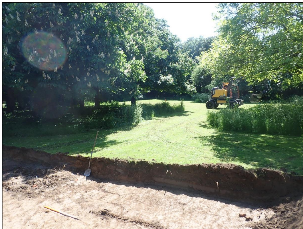
Afbeelding 3. Binnen het plangebied waren veel bomen aanwezig, waardoor de proefsleuven niet op de geplande locatie konden worden aangelegd.
