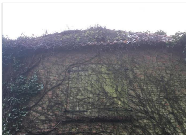
Afbeelding 4.14 | Geschikt ruimte voor huismus tussen gevel en dakpannen.
