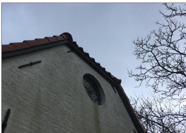
Afbeelding 4.13 | Geschikt ruimte voor huismus en gierzwaluw tussen gevel en dakpannen.
