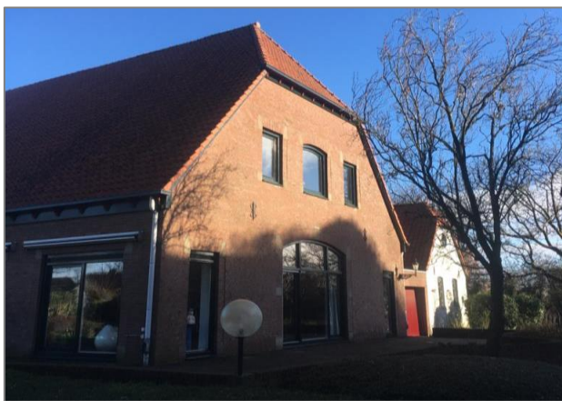
Afbeelding 1.1 | Voorzijde en zijgevel woning.
