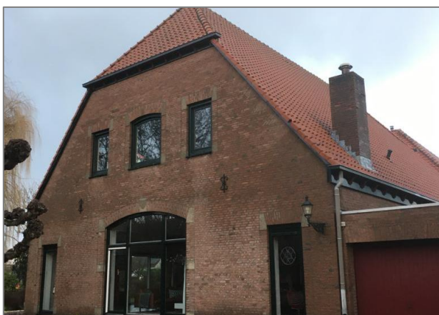
Afbeelding 4.3 | Spouwmuur aanwezig in woning.
