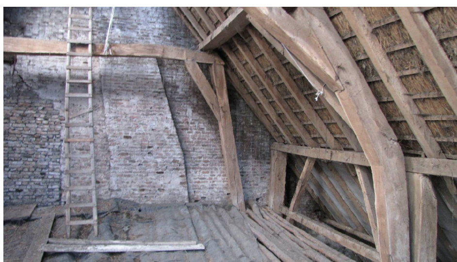
Afbeelding 2. Balkenconstructie met pen-gat verbindingen.
