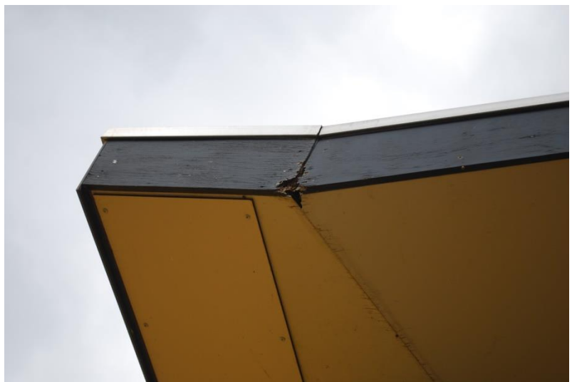
Gat in oversteek laagbouw noordkant (links), evenals aan de zuidkant (rechts)
