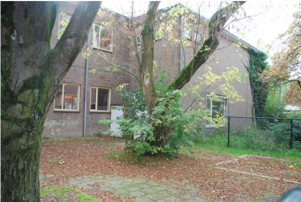
Noordkant, met klimop tegen noordwesthoek
