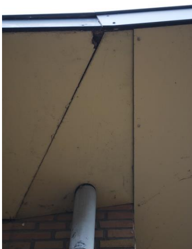
Gat in oversteek laagbouw noordkant (links), evenals aan de zuidkant (rechts)
