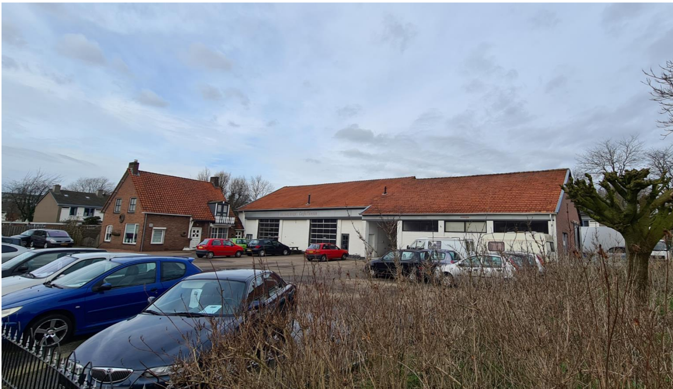
Figuur 1: Woonhuis en garage gezien vanuit de oosthoek
