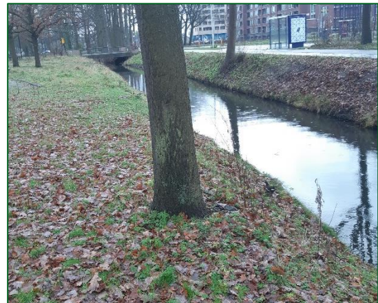
afb. 4: boom 3 staat dicht op de slootwal, waardoor de benodigde kluitgrootte niet haalbaar is
