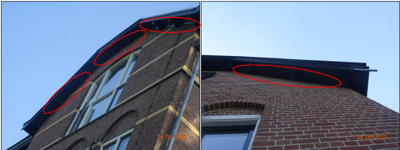
Afbeelding 6.1: Aantal aanwezige panden met locaties geschikt als verblijfplaatsen van vleermuizen (rood kader).
