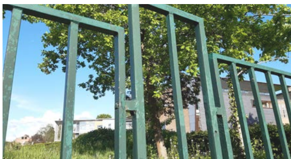
Hekwerk aan rand van het plangebied ter hoogte van de Arboretumlaan
