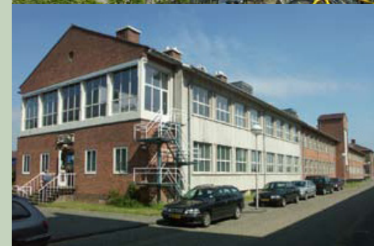
Scheikundegebouw: sober, alzijdig, variatie door baksteen te combineren met glasvlakken in betonnen kaders
