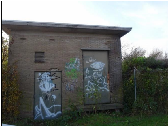
Figuur 1. Transformatorhuisje in het plangebied De Drijen.
