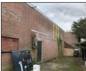
Figuur 10. Achterzijde Churchillweg 25.
