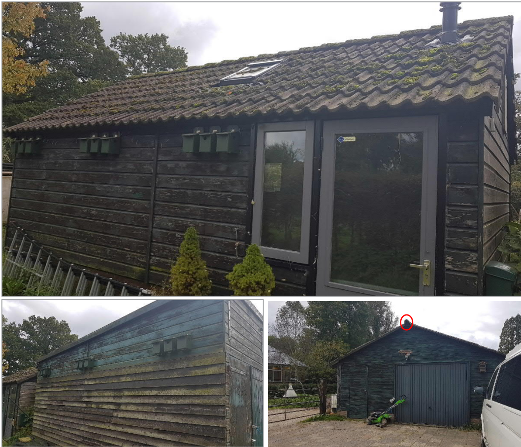
Figuur 3.12 Boven het dak waaronder de huismussen het isolatiemateriaal halen, mogelijk zitten hier ook nesten. Aan dit gebouw en het gebouw ernaast zijn huismuskasten opgehangen (boven en linksonder). Ook is bij een ander gebouw de nok open waar mogelijk ook nesten in kunnen zitten (rood omcirkeld in de afbeelding rechtsonder).
