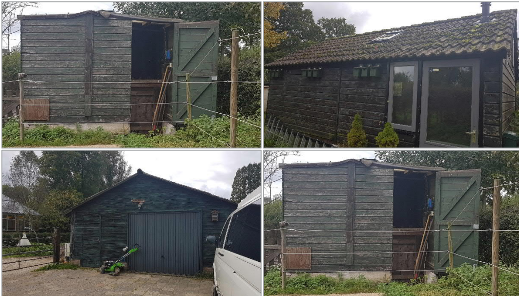
Figuur 3.6 Bebouwing aan de Grintweg nr. 277.
