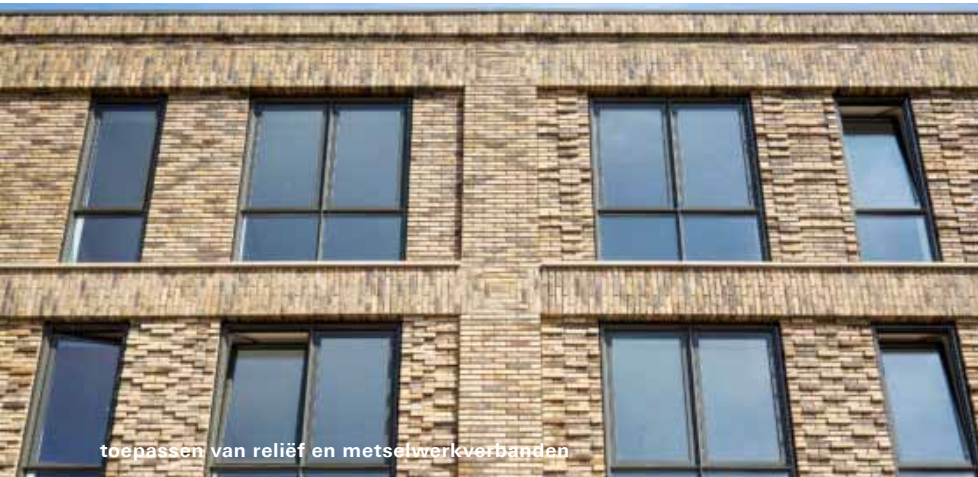
toepassen van reliëf en metselwerkverbanden
