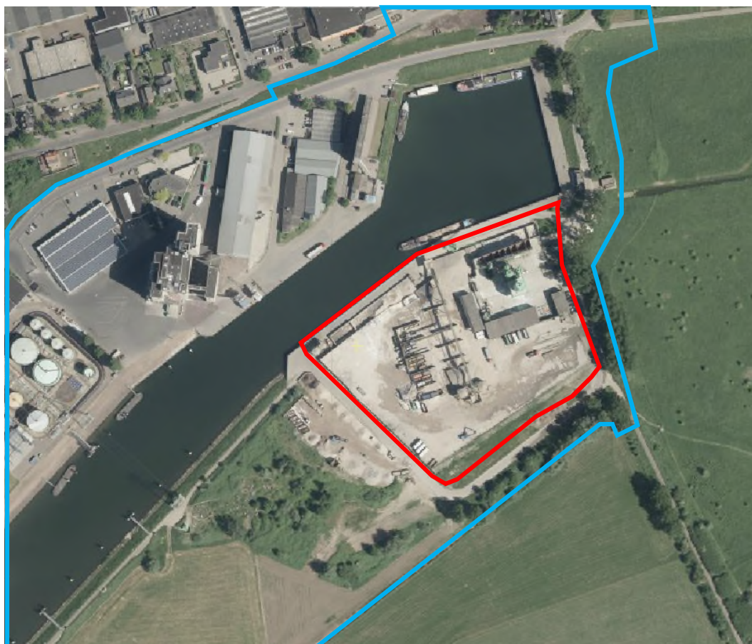
Figuur 5-2: Locatie ontwikkeling 2: Verwijderen bedrijventerrein (rood) en het plangebied (blauw) (LuchtfotoNL 2017 © CycloMedia Technology B.V.)
