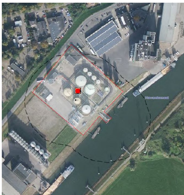
Figuur 3.1: Ligging PR 10^{-6} -contour (stippellijn) van Varo Energy Terminal Wageningen (gegevens Risicokaart)
