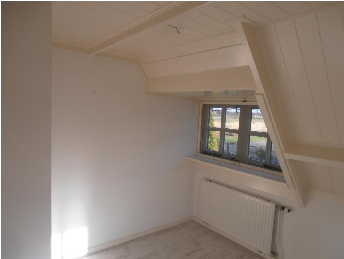
Slaapkamer - zicht op straatgevel t.p.v. dakkapel
