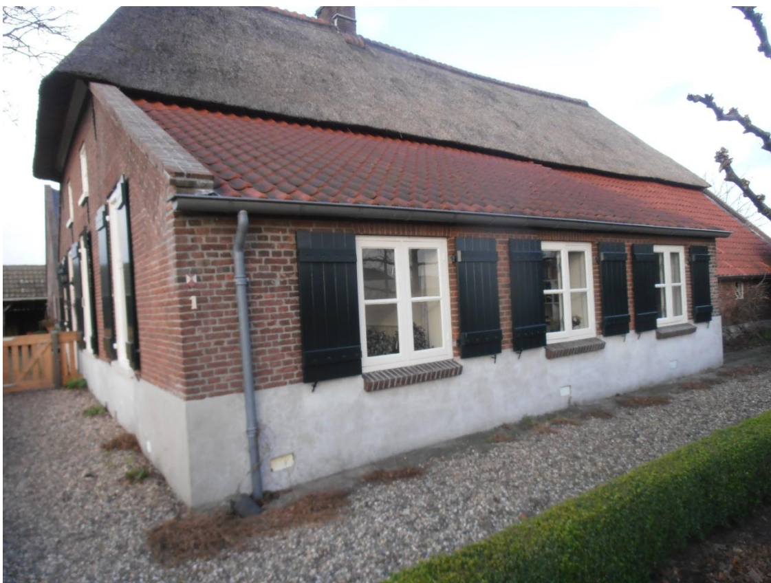
Voor- en zijgevel woning Kielekampsteeg 1
