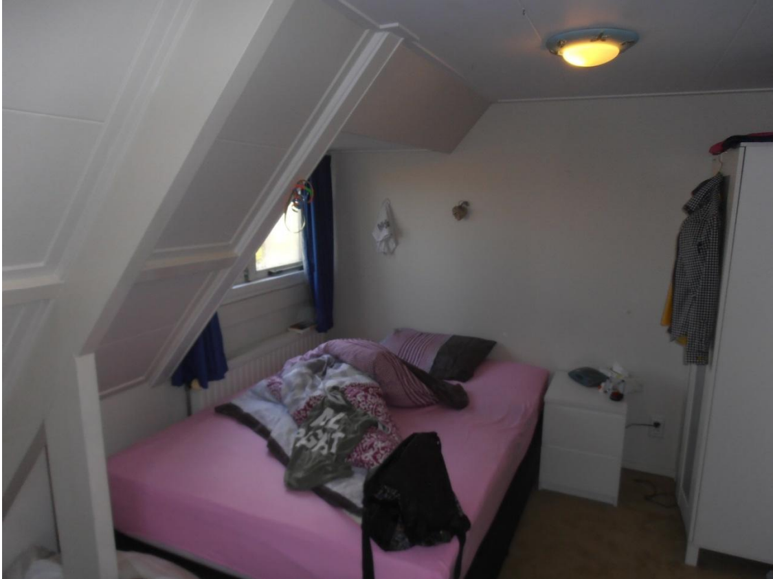
Slaapkamer 1 e verdieping zicht op straatgevel en woningscheidende wand
