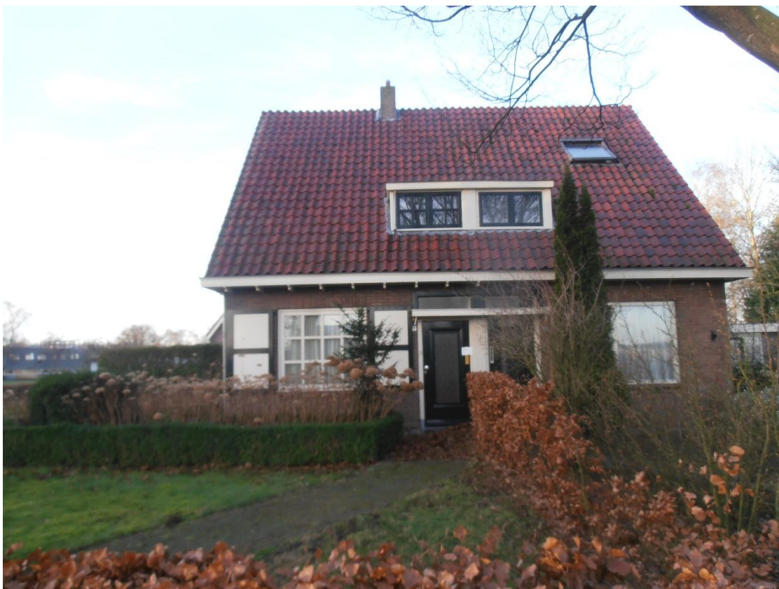
Voorgevel woning Bornsesteeg 71 (links) en 73 (rechts)
