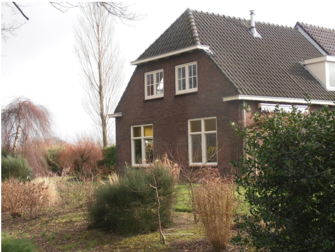
Voor- en rechterzijgevel woning Kielekampsteeg 34
