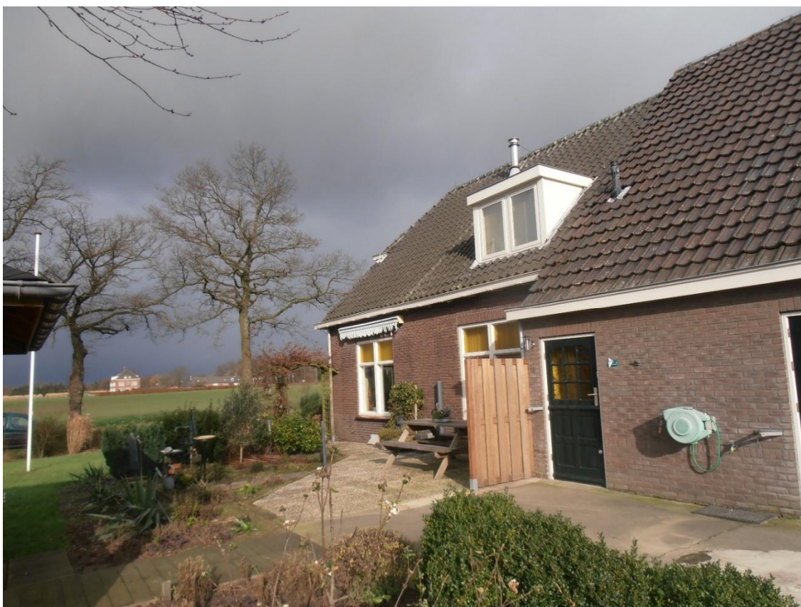
Rechterzijgevel woning Kielekampsteeg 34
