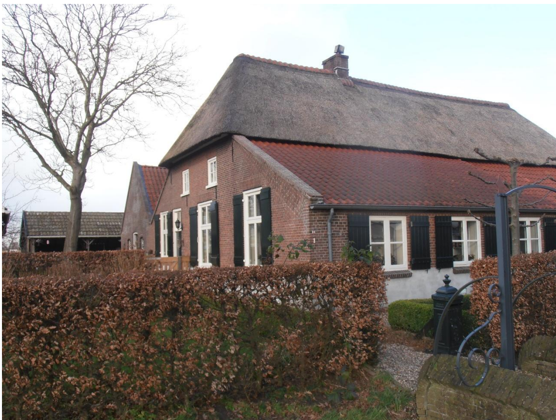
Voor- en zijgevel woning Kielekampsteeg 1
