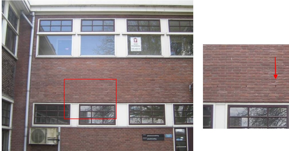
Afbeelding 5: mogelijke toegang tot verblijfplaats vleermuizen.
