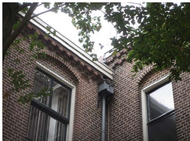
Fig. 4. Detail van het oudere deel van het gebouw, waar de uitbreiding plaatsvindt
