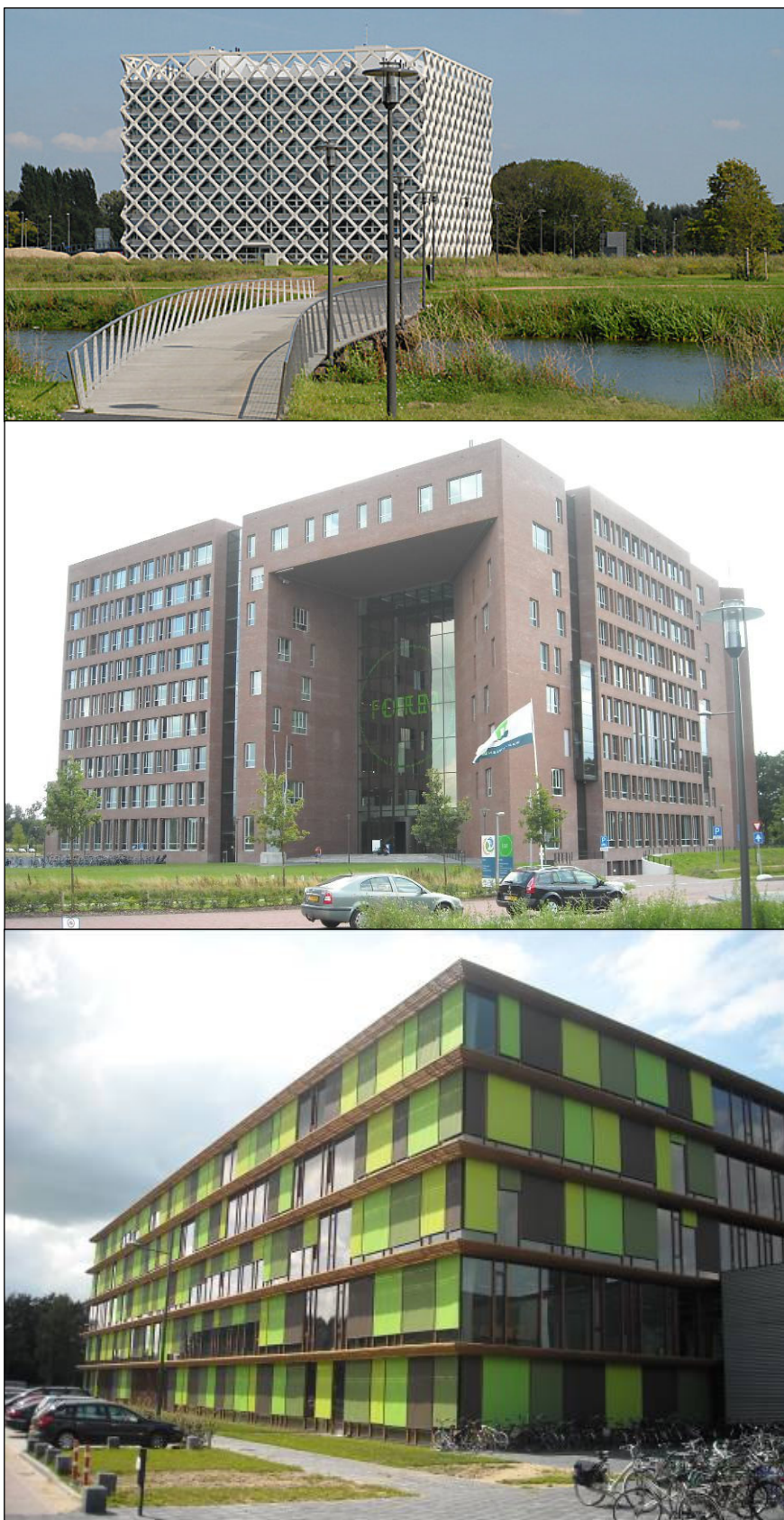
Afbeelding 3: Het Atlasgebouw (boven), het Forumgebouw (midden) en het gebouw Radix (onder)
