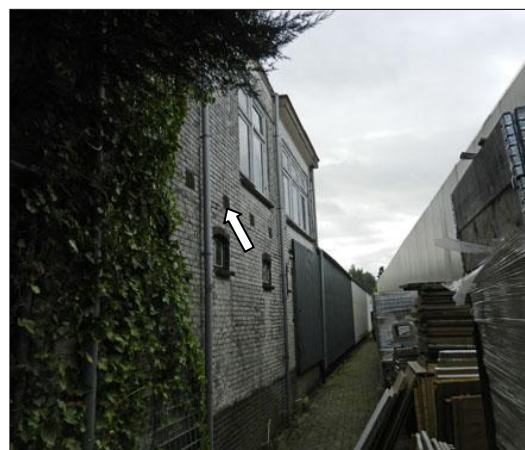
Figuur 6: Aan de achterzijde van de woning zijn ventilatieopeningen aanwezig die aan vleermuizen toegang kunnen bieden tot de spouwruimte.
