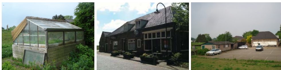
Foto's: De te slopen kas, het te verbouwen café en de parkeerplaats.
