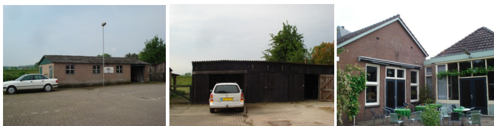
Foto's: De te slopen opstallen.
