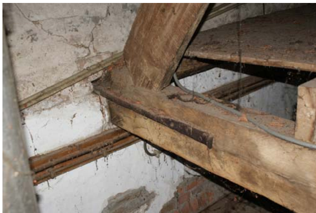
Eiken trekbalk met muuranker en spantbeen
