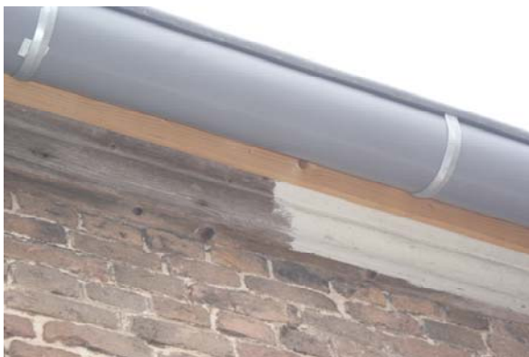
Detail van oude geprofileerde gootlijst (oostzijde)
