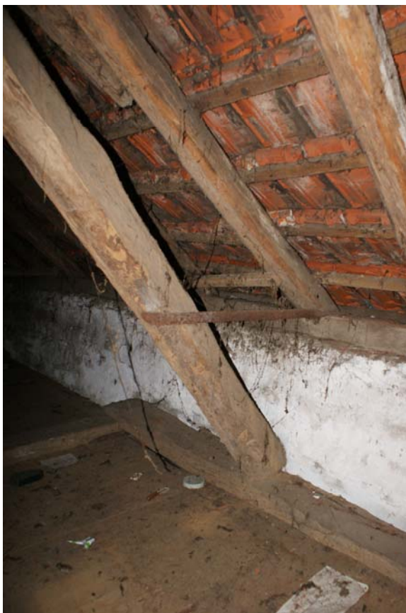
Eerste spant steunt op onderslag
