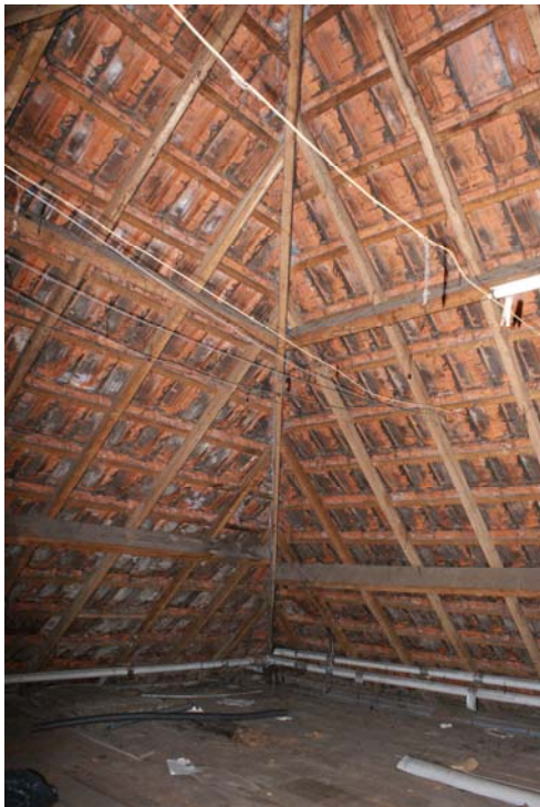
Kapconstructie boven het café
