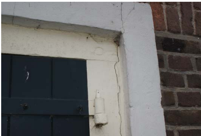
Detail oude staldeurkozijn met toognagelverbinding
