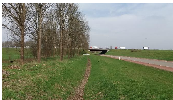
Afb. 4. Situatie tracé 2 met links de bosschage en rechts de rijbaan.
