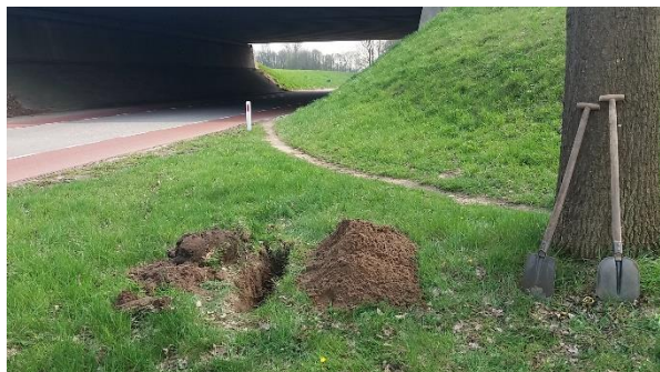
Afb. 33. Locatie proefsleuf bij boom 10 op 2.2 meter afstand vanuit het hart van de stam.
