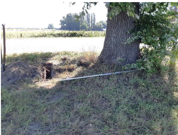
Afb. 31 Proefsleuf op 2 meter afstand vanuit boom N35. Dit is de afstand waarom de aansluiting met de huidige rijbaan zal worden aangelegd.
