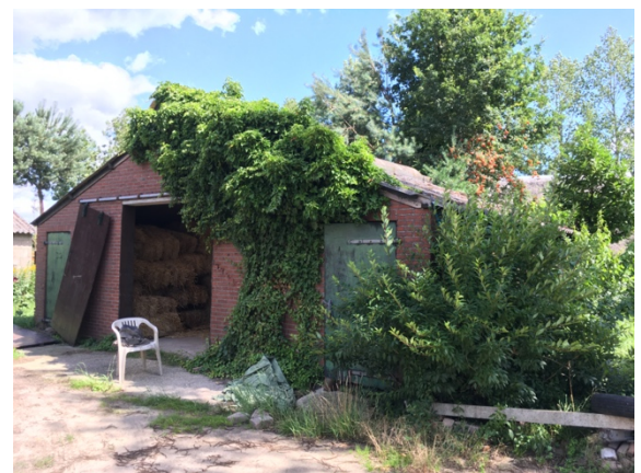
Figuur 9. Schuur (gebouw 5).
