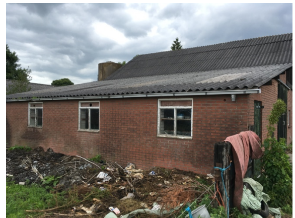
Figuur 7. Stalgedeelte van gebouw 4.
