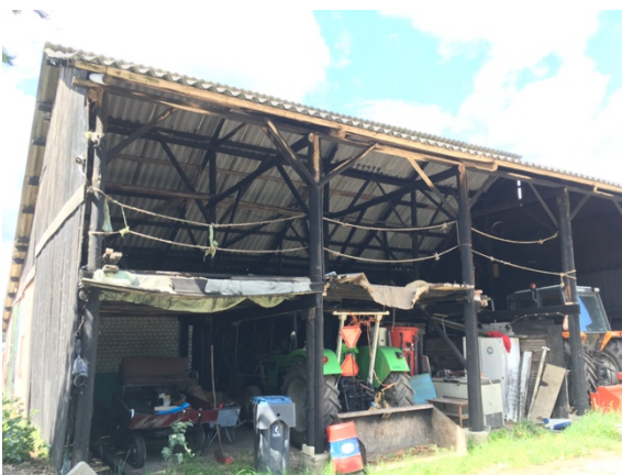
Figuur 8. Kapschuurgedeelte van gebouw 4.
