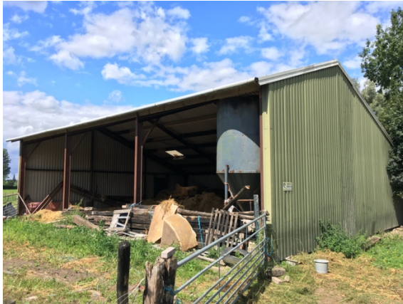
Figuur 4. Kapschuur (gebouw 1)
