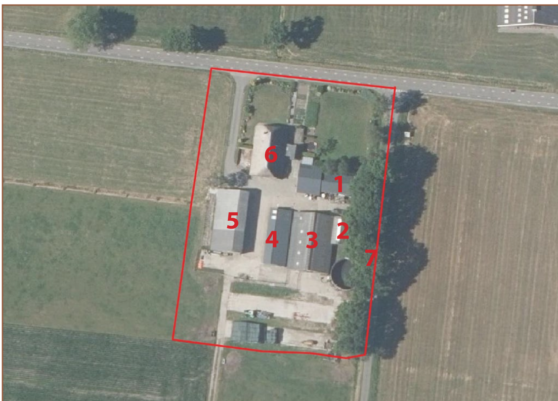
Afb. 1.2: Het erf in huidige toestand (rood kader). 1 = te slopen deel schuur waarvan het westelijk deel behoude blijft, 2 en 3 = te slopen stallen, 4 = te slopen schuur/berging, 5 = te behouden kapschuur, 6 = bestaande woning met aangebouwd kookhuis, 7 = bomenrij. Bron ondergrond: PDOK.nl/viewer, luchtfoto 2019.
