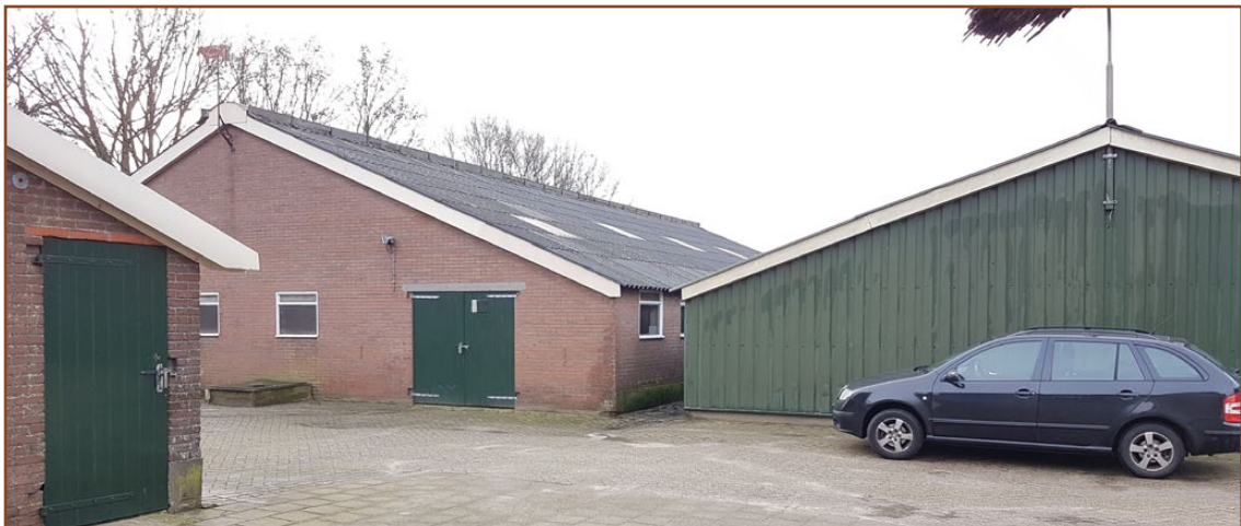
Afb. 2.2: Te slopen bijgebouwen 3 (links) en 4 (rechts) gezien vanaf de woning. Uiterst links de deels te behouden schuur naast de woning.
