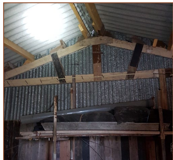
Afb. 2.4: Binnenkant schuur 4. Er zijn nergens besloten ruimtes voor vleermuizen. Nesten of gebruikssporen van vogels ontbreken.
