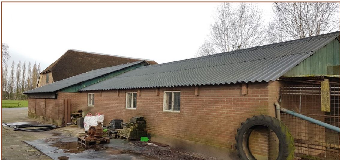
Afb. 2.5: Gedeeltelijk te slopen schuur. Het gedeelte linksachter (tot waar de gevel verspringt) blijft behouden, de rest wordt gesloopt.
