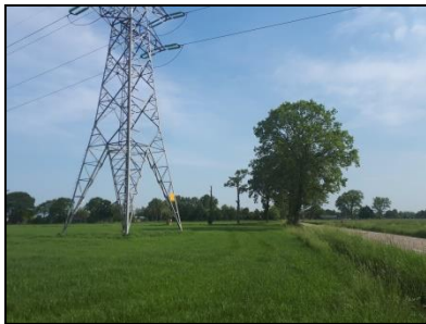
Figuur 3. Noordoostelijk deel onderzoekslocatie met hoogspanningsmast.
