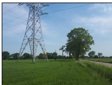
Figuur 3. Noordoostelijk deel onderzoekslocatie met hoogspanningsmast.
