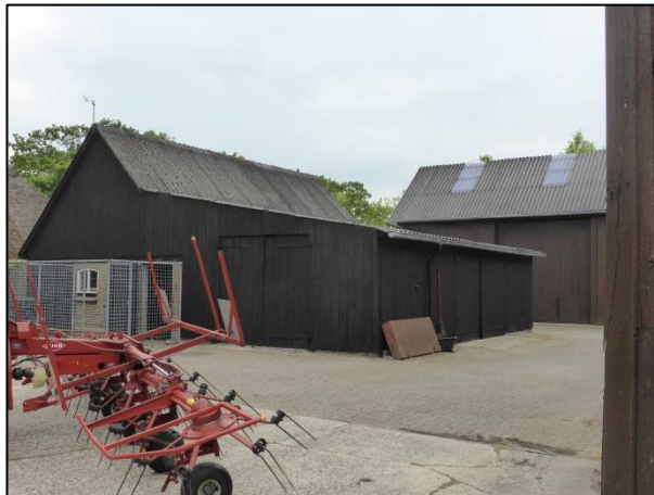
Afbeelding 4: werkplaats waar het lage deel van gesloopt wordt.
