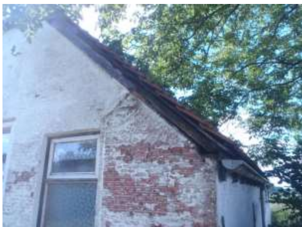
Foto 5, de windveer waarvan het opstaande deel is verrot. Op deze locatie bevonden zich oude nesten van de huismus.
