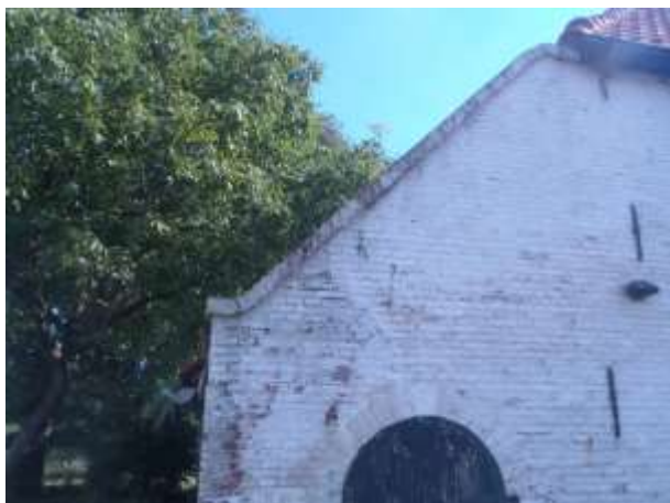
Foto 4, detail achtergevel, gemetselde rollaag met nog juist zichtbaar het wolfseinde met goot (noordgevel)
