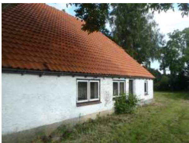
Foto 2, de westgevel van de boerderij
