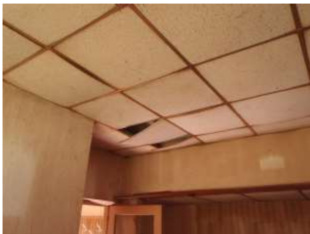
Foto 9 , plafond in het woongedeelte van platen zachtboard onder de balklaag.
