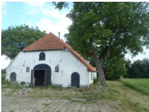
Foto 1, de te slopen boerderij vanuit noordelijke richting. Rechts op de foto de walnoot met holten die behouden blijft.
