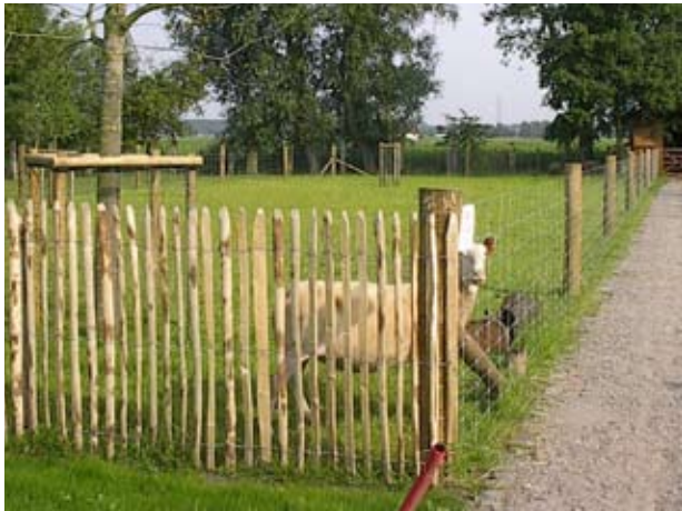
Kastanjehoutenhekwerk en palen met gaas
