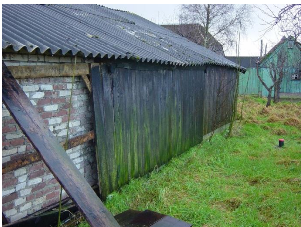
Foto 2, betimmering van ruwe binnenmuur, mogelijke verblijfplaats voor vleermuizen
