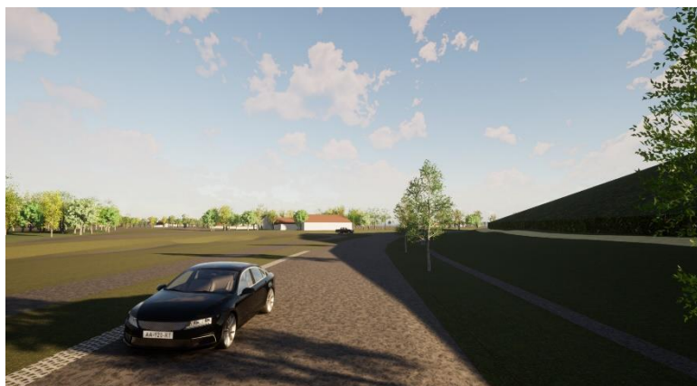
Figuur 6-23 Schaduwwerking Sluinerweg alternatief 3 (gezicht 2) i.r.t. referentiesituatie op 21 juni omstreeks 20:00, door schaduwwerking is het kruisingsvlak minder goed zichtbaar. (B= alternatief 3, O=Referentiesituatie)
