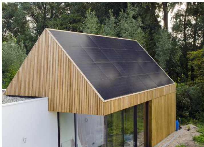
Geïntegreerde zonnepanelen
