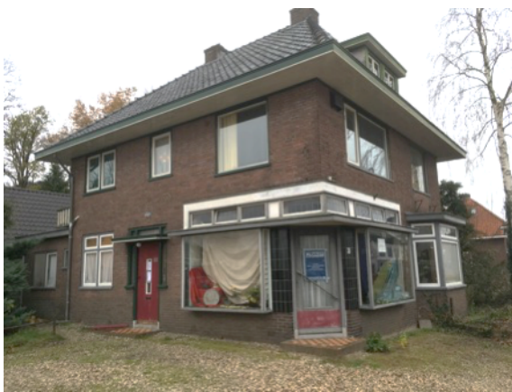
Figuur 3. Noordwestzijde woning.
