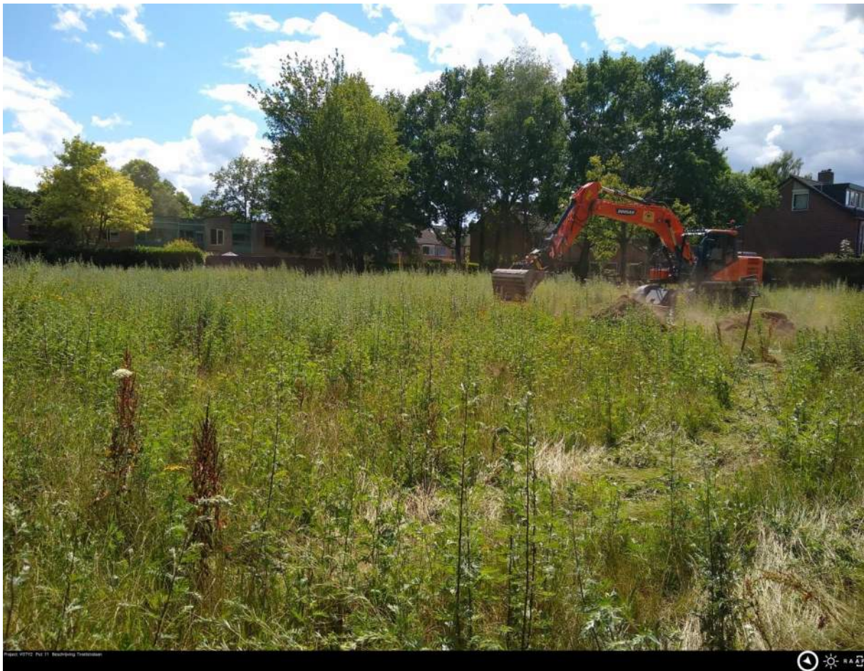
Figuur 2: Het plangebied aan de Troelstralaan was sinds de sloop van de bebouwing overwoekerd geraakt met onkruid.
