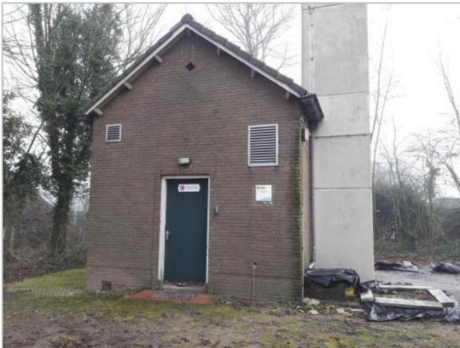
Gebouw van huidig rioolgemaal
