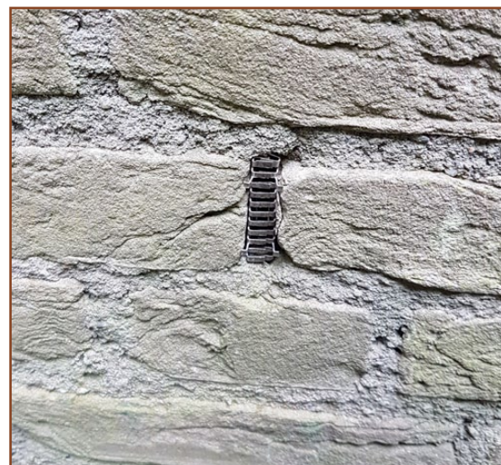
Afb. 2.5: De open stootvoegen in de gevels zijn allen dichtgezet met roosters en daarmee ontoegankelijk gemaakt voor bijvoorbeeld vleermuizen.
