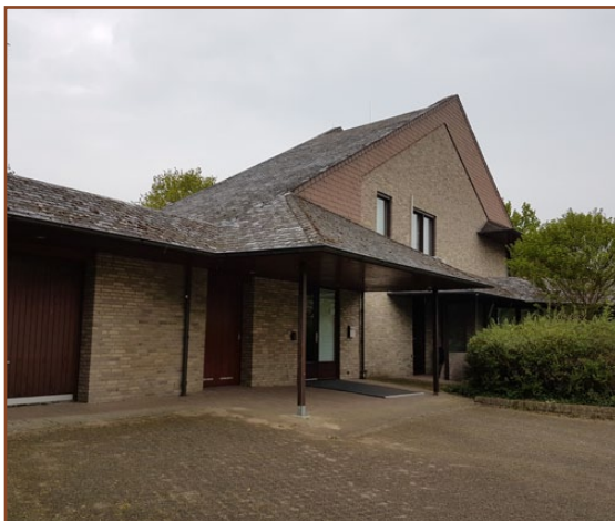
Afb. 2.2: Hoofdentree van het bestaande pand (zuidoostkant).
