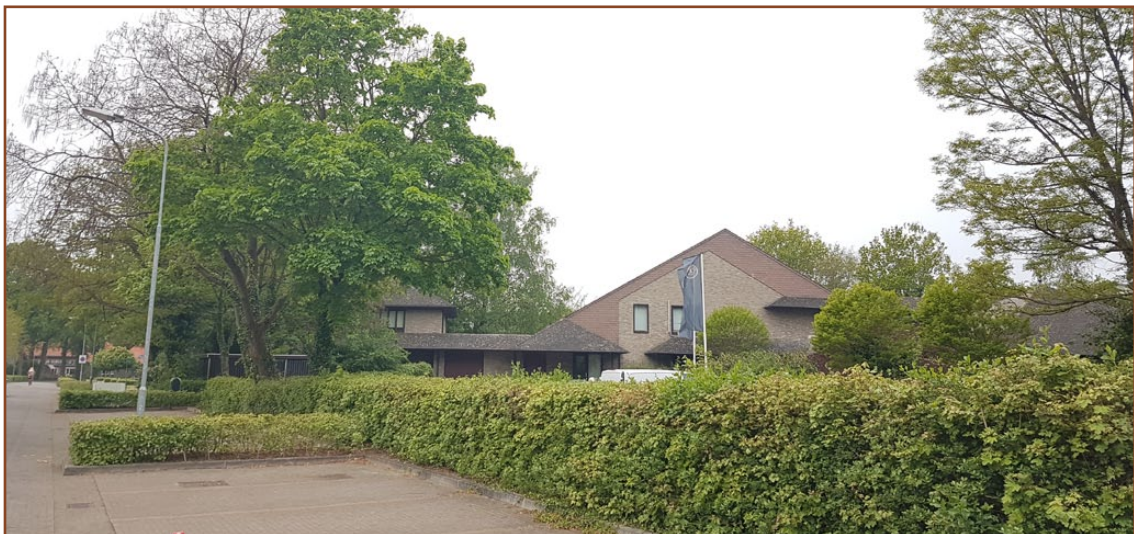
Afb. 2.1: Het te slopen pand aan de IJsaanweg 7, gezien vanaf de parkeerhavens tegenover de school ten zuiden van het plangebied.
