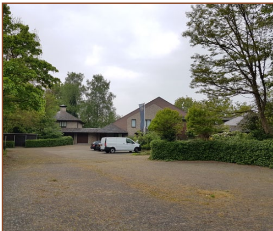
Afb. 2.7: Uitzicht over het zuidelijke parkeerterrein met op de achtergrond het te slopen pand.
