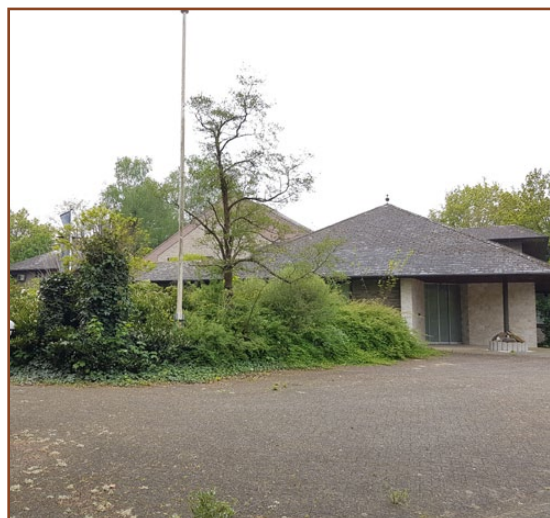
Afb. 2.10: Noordoostelijk deel te slopen pand.
