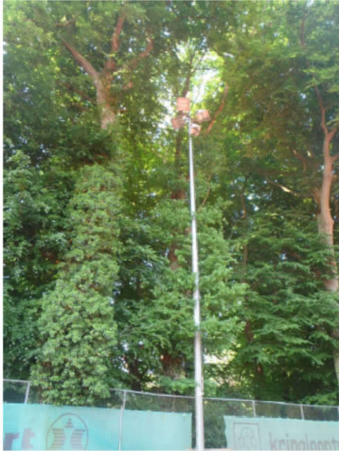
Foto 4: een van de zes aanwezige masten met een viertal armaturen in alle richtingen.
