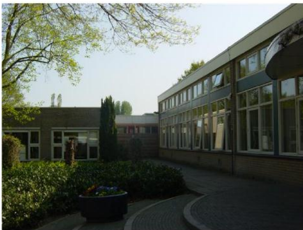
Foto 11, de zijde van de hoofdingang aan de Meester Zwiersweg.
