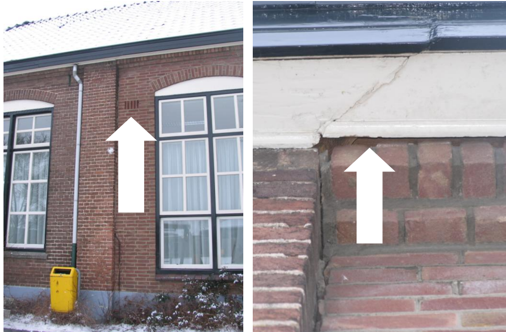
Afbeelding 5: Toegankelijke spouwmuur (links) en toegangsgaten tot onder het dakbeschoot / zolder (rechts) in het Dorps huis (foto's SAB, 2013)
