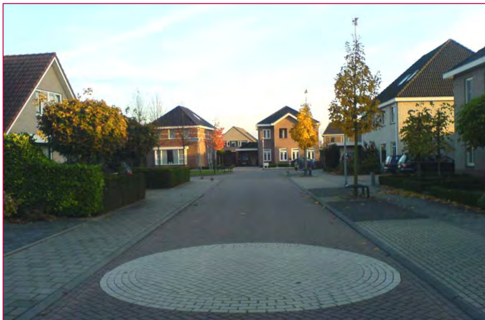
Foto 4.1: Ronde verkeersdrempel in de Van de Venstraat
