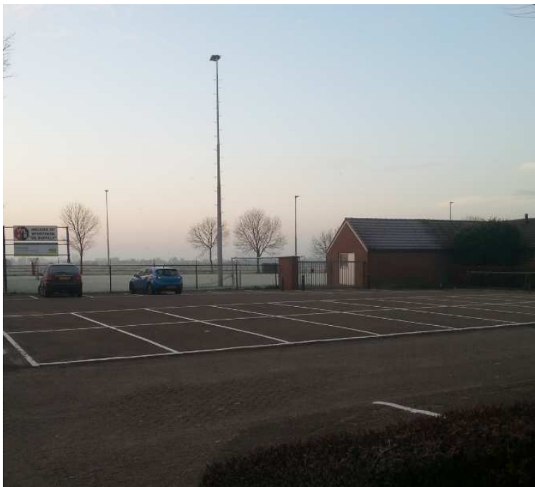
Openbare parkeerterrein met uitzicht op bestaande tweede sportveld en deel bestaande bebouwing (foto buro Waalbrug).
