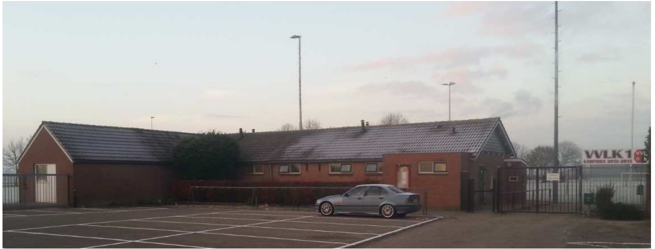
Bestaande bebouwing (o.a. kleedruimten) VVK (foto buro Waalbrug).
