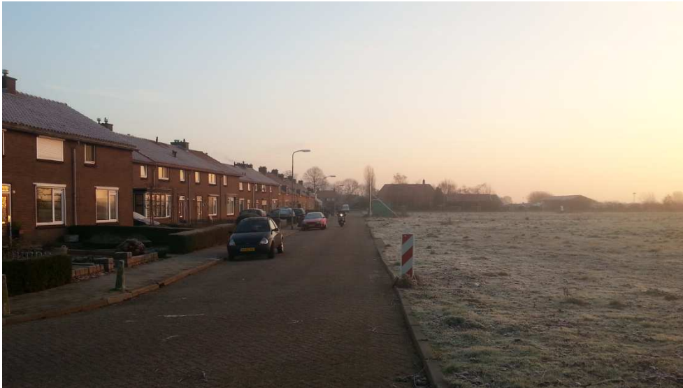
Pastoor van Tielstraat, de rechterzijde van de straat (thans braakliggend) maakt onderdeel uit van het plangebied (foto buro Waalbrug).
