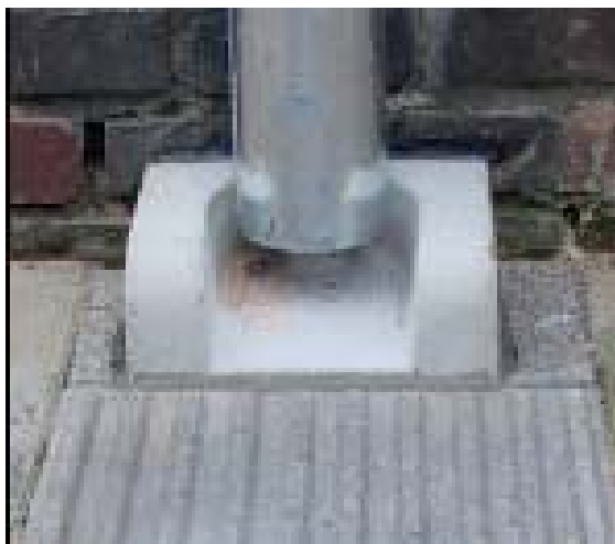
Figuur 11: regenvijl eindigend boven de grond
