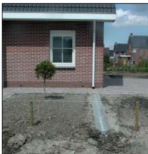
Figuur 12: gootje om hemelwater af te voeren
