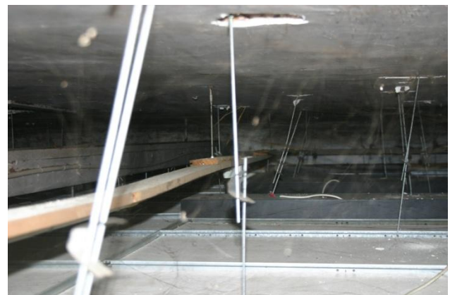
Foto: Ruimte tussen plafond en verdieping
