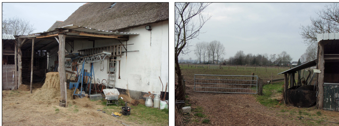
Figuur 3.1 Overzichtsfoto's van de deelgebieden 1 (A: linkerfoto) en 2 (B: rechterfoto), dd. 10-02-2011. A: Foto genomen vanuit het zuidoostelijke deel van deelgebied 1 kijkende in noordwestelijke richting. Op de voorgrond is het te slopen houthok/-schuurtje te zien met aangrenzend erf. B: Foto genomen direct ten zuiden van deelgebied 1 kijkende in de richting van het zuidelijke deel van deelgebied 2 ter plekke van het grasland. Op de foto is zichtbaar dat het maaiveld achter het hek geleidelijk aan oploopt. Het verschil in hoogte tussen deelgebied 1 en 2 betreft circa 40 cm.
