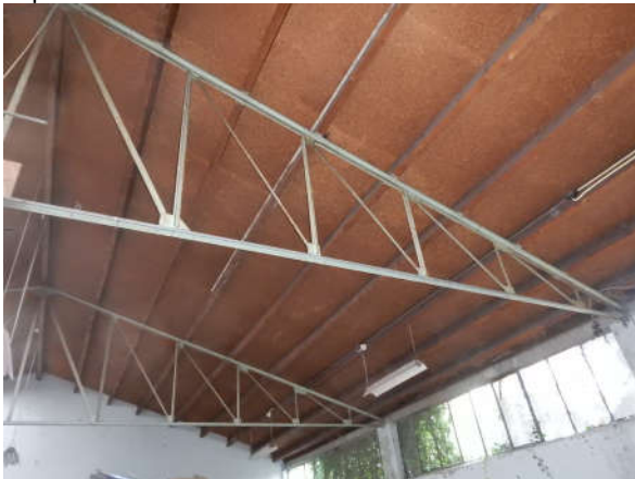
Impressie van de binnenzijde van de loods (2)
