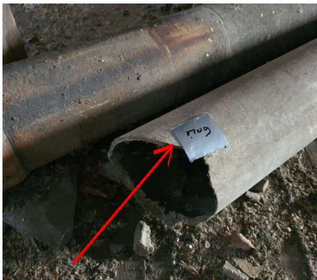
Bron 9, M09 buismateriaal (1)
