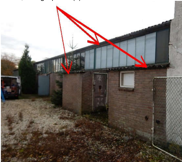
Bron 2, golfplaten aanbouw
