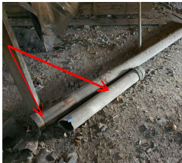
Bron 9, M09 buismateriaal (2)
