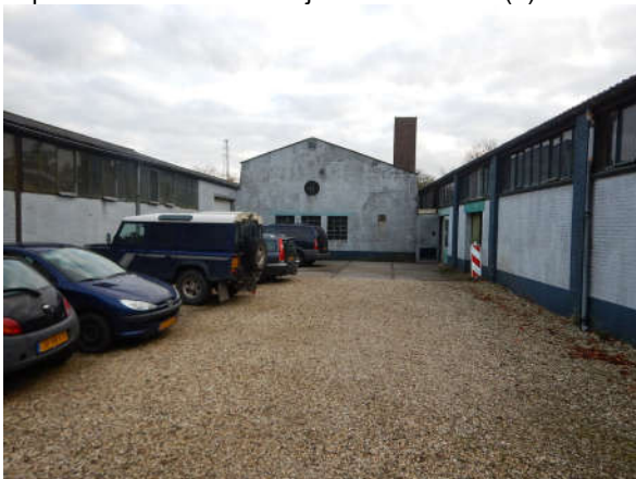
Het rookgaskanaal is gemetseld
